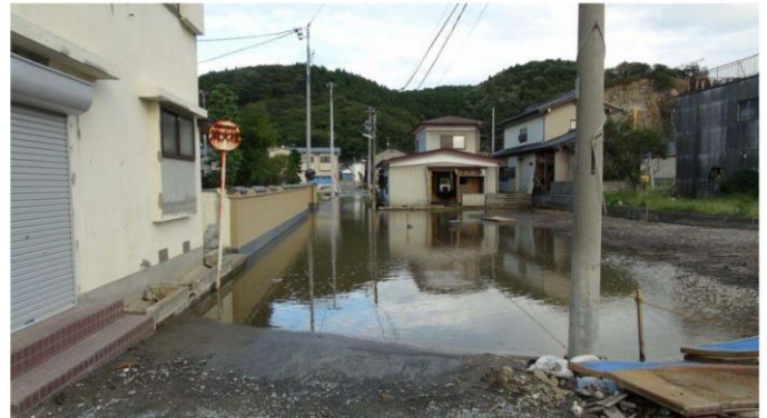
2011年9月23日 宮城県石巻市八幡町2丁目 道路も容赦なく冠水しています。毎日夕方になると通れない道ができていました
